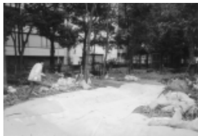
ベントナイトシートの敷き込み
